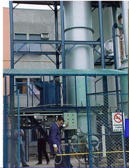
Bubbling bed gasifier
