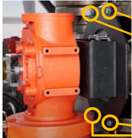
รูปที่ 1 ชี้ให้เห็นน็อตที่ยึด แทนของ actuator เข้ากับ ตัววาล์ว
