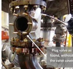
*Figura 3. Válvula tras el incidente.*
