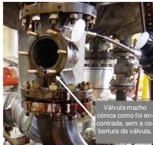
*Figura 3. Válvula após o incidente*
