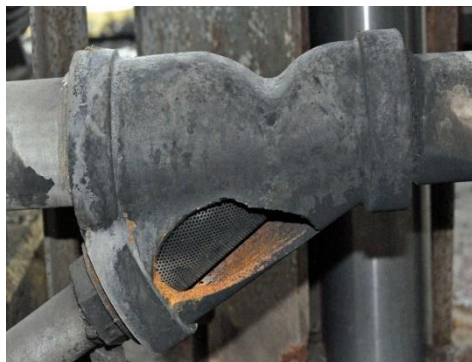
Rys 1. Żeliwny filtr siatkowy Y niewłaściwie zamontowany w spawanej linii ze stali nierdzewnej.
