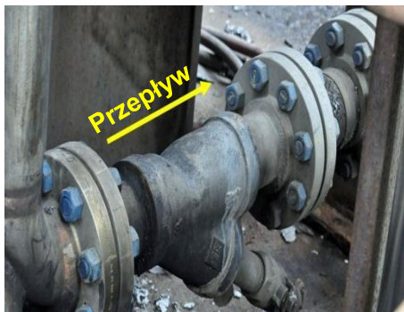
Rys 1. Żeliwny filtr siatkowy Y niewłaściwie zamontowany w spawanej linii ze stali nierdzewnej.
