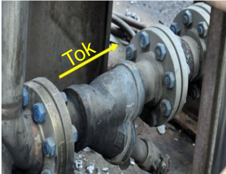
Obrázek 1: Nesprávně instalovaný litinový filtr tvaru Y na svařovaném potrubí z nerezové oceli.
