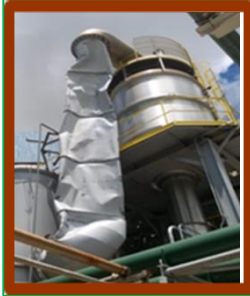
Figura 1: Conducta de admisie către un uscător s-a deteriorat sub vid
