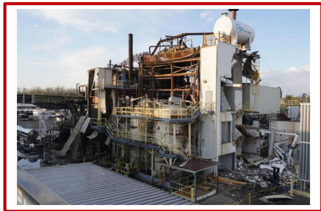
Figura 1. Prédio do reator após a explosão interna (Fonte: relatório do CSB No. 2021-04-I-OH)
