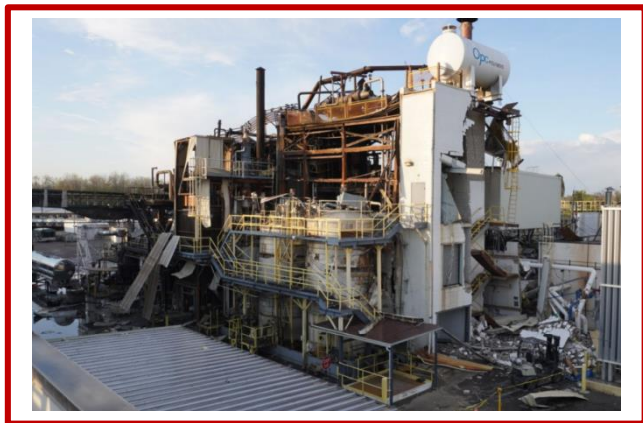
Fot. 1. Budynek żywic po wybuchu wewnątrz (Źródło: CSB report No. 2021-04-I-OH)
