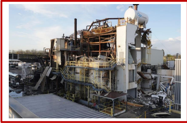
شکل ۱: ساختمان رزین بعد از انفجار داخلی
