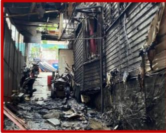
図1 リチウムイオン電池火災による建物の被害
