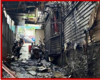
Abb. 1: Gebäudeschaden, verursacht durch Brand eines Li-Ionen-Akkus.
