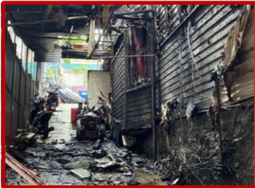
Figure 1 : Dommages aux bâtiments causés par un incendie d'une batterie lithium-ion.
