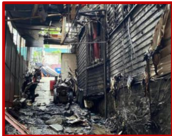
Obrázek 1: Škody na budovách způsobené požárem Li-Ion baterie.
