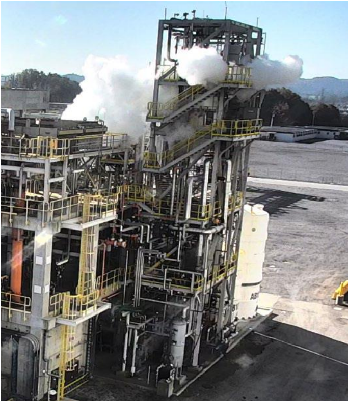
Figura 1. Plataforma donde ocurrió la fuga. Quince segundos más tarde, la nube envolvía la estructura. (Ref CSB report No. 2021-01-I-TN)
