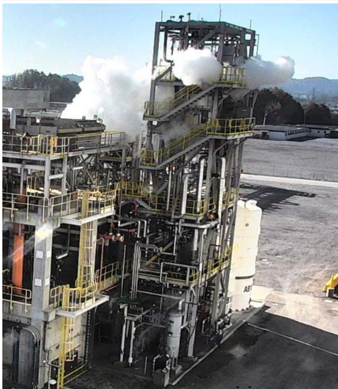
*Рис. 1. Платформа, на которой произошел выброс. Пятнадцать секунд спустя сооружение было охвачено облаком. (Ref CSB report No. 2021-01-I-TN)*
