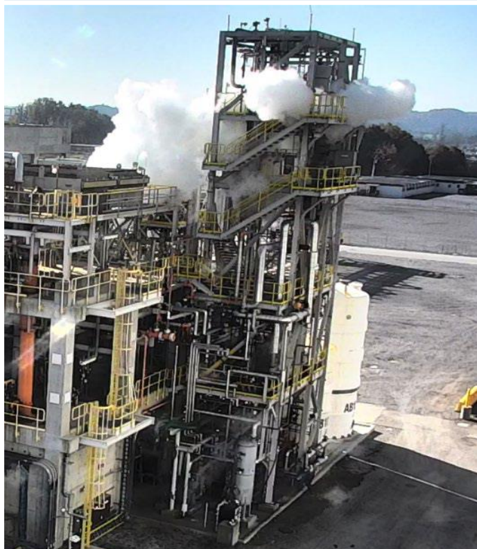
Figura 1. Plataforma onde ocorreu o vazamento. Quinze segundos depois, a estrutura foi engolida pela nuvem. (Ref.: relatório do CSB No. 2021-01-I-TN)
