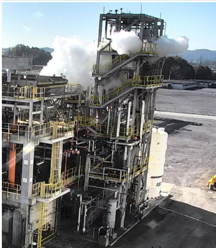
Figura 1. La piattaforma dove è accaduto il rilascio. 15 secondi più tardi la struttura è stata inglobata dalla nube. (Ref CSB report No. 2021-01-I-TN)
