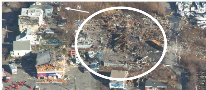
Hình 1: Thiệt hại của nhà máy sơn sau vụ nổ
