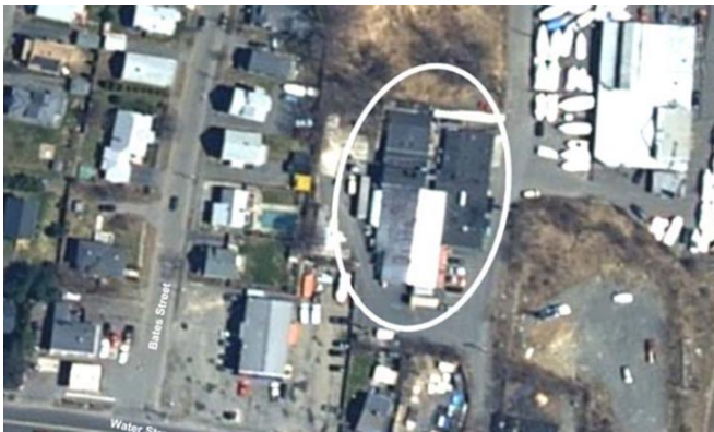
Figura 2: L'impianto di verniciatura prima dell'esplosione
