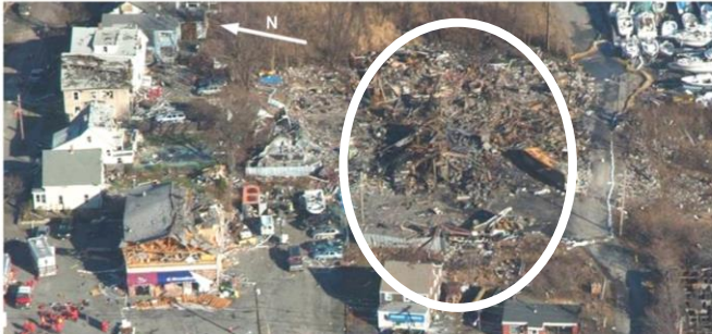
Figura 1: Impianto di verniciatura danneggiato dall'esplosione
