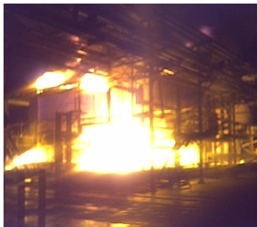
Obrázek 1: Požár nádrží po úderu blesku
