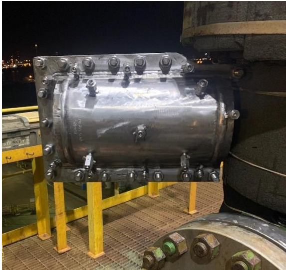
Εικόνα 1. Ένα προσωρινό κούτι στεγάνωσης πάνω από μία βάνα που είχε διαρροή
