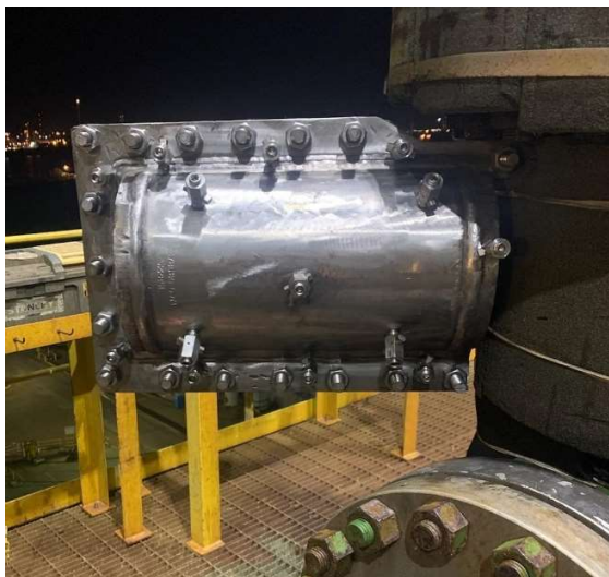
圖 1. 已洩漏的閥門套上臨時管夾
