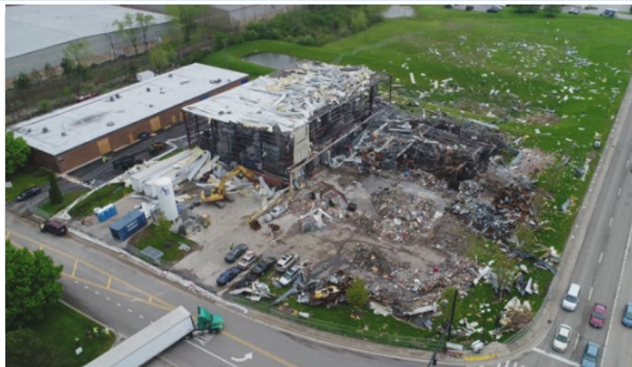
Bild tagen efter explosion vid AB Specialty Silicones anläggning. (Referens CSB-rapport Nr. 2019-03-I-IL)
