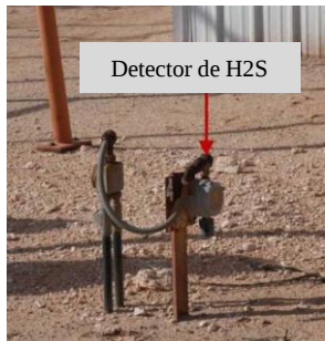
Fig. 1: Unul dintre detectoarele de H 2 S
