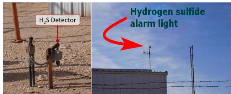
Obr. 1: Jeden z detektorů H 2 S. Obr. 2: Výstražné světlo alarmu H 2 S
