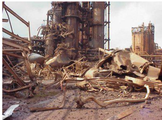
Zniszczenia po wybuchu BLEVE
