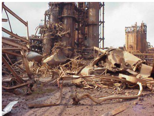
Schade tengevolge een BLEVE
