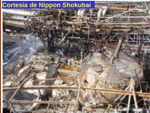
Foto 1: Tanque de AA destruido
