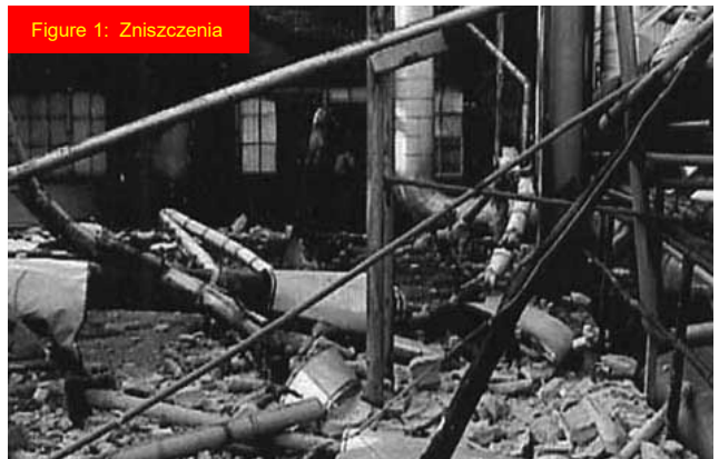
Figure 2: Uszkodzony rurociąg
