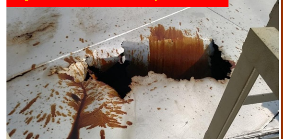
Fig. 3 : Trou au sommet du bac d'hydrocarbures
