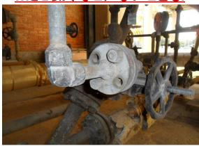
写真は あるプラントの 安全検査で見つかったボルト 締めが適正でないフランジである。上段の写真では、 ボルトの何本か、もしくは全てが短かすぎて、ナットが ボルトに完全に掛かっていない。このことは継手がその あるべき強度になっていないかもしれないことを意味し ている。フランジはすべてのナットとボルトの組合せで フランジへの力を保持するように設計されている。もし、 ナットがボルトに部分的にしか掛かっていないなら、継 手は充分な強度がないかもしれない。左の写真では4 本のボルトのうち2本があるべき所にない。このフランジ では配管設計者が意図したものの約半分の強度しか ないだろう!
