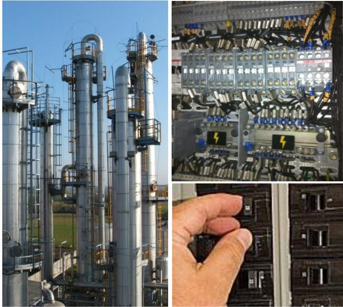
정비부서 작업자가 비프로세스 전기회로를 차단하고자 전기실로 들어갔습니다. 실수로 플랜트의 프로그래밍 가능한 논리제어기(programmable logic controller, 이하 PLC) 전원용 차단기를 작동시켰습니다. 그는 잘못을 깨닫고 PLC 회로 차단기를 재설정하고는 목적인 전기회로 차단기를 끊었습니다. 하지만 한 순간의 PLC로의 전기공급 중단으로 일부 프로세스 장치가 가동 중지되었습니다. 그 결과 부분적인 컨트롤만으로 프로세스는 가동되게 되었습니다. 프로세스 운전이 혼란하게 되고, 차단 밸브가 닫히며 독성물질이 벤트 scrubber 용량을 초과해 배출되었습니다. 다행히 아무도 부상을 당하지 않았고 유출은 플랜트 사이트에만 국한되었습니다.
