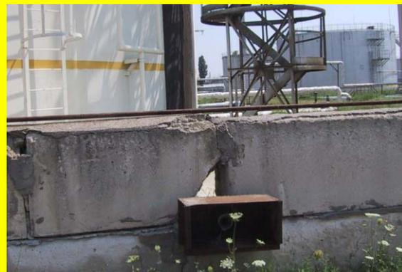
Июнь – разрушение (дырка) в стенке защитного ограждения емкости
