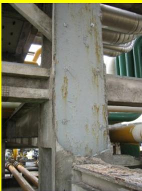
Май – повреждение огнезащиты поддерживающей колонны лотка (моста) для технологических труб
