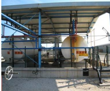
Muchas personas reconocen que los diques, alrededor de tanques de almacenamiento, y losas de contención para bombas, edificios y estructuras de proceso, áreas de descarga de camiones y trenes, y otros lugares con potencial de derrames, tienen una importante función de protección ambiental – prevenir la contaminación del suelo y de agua superficial. ¿Pero sabe Ud. que a menudo tienen también importantes funciones de seguridad? Algunos ejemplos incluyen:
