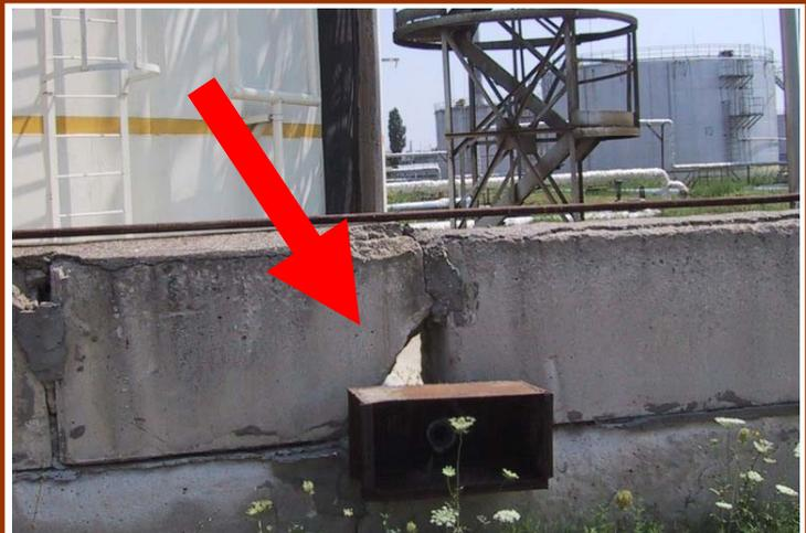
La flecha muestra un hoyo en un dique de contención. Más daño puede verse en la base y en el tope del muro del dique.
