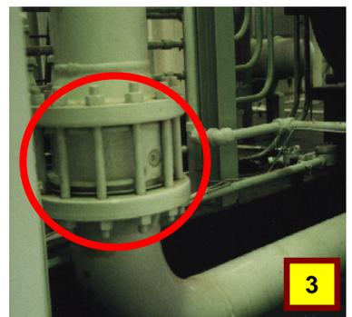
你能识别出图 1 中(黄色箭头)所示的金属罩子是一件重要的安全装置吗? 如果它受损或缺失的话, 你知道需要报告使之得到维修或更换吗?
