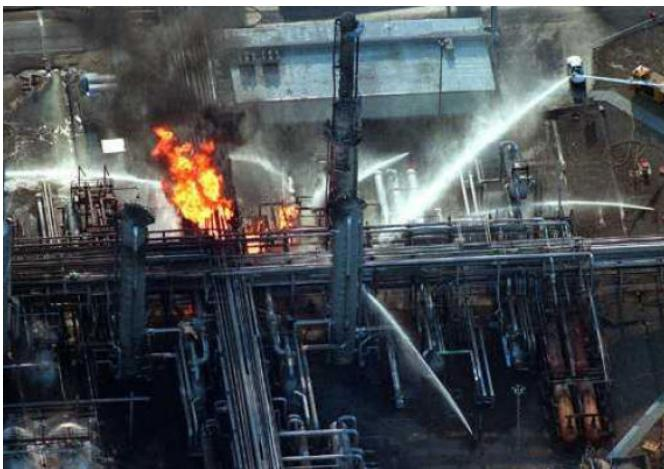
flusso di olio caldo ha provocato uno stress ulteriore. Ciò ha provocato una rottura per fragilità dello scambiatore di calore. E' stata così rilasciata una nube vaporizzata e si è stimato che contenesse più di 10 tons di gas infiammabile che ha immediatamente preso fuoco.
