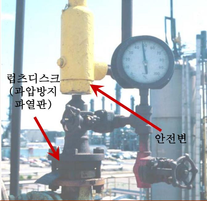
압력용기에 과압방지를 목적으로 과압방지 파열판(럽츠디스크)과 안전변이 연속적으로 설치되어 있습니다. 그 파열판과 안전변 사이에는 압력계가 설치되어 있습니다. 통상 공정순찰 시에 이 압력계를 확인하게 되어 있습니다. 정상적으로는 압력계가 제로로 가리켜야 합니다. 오늘 당신이 사진에서와 같이 50 psig (~3.5 barg)가 표시됨을 목격했습니다.
