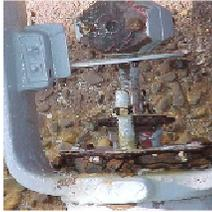
La foto de la izquierda muestra una válvula de control corroída. ¿Contaría Ud. con que esta válvula va a operar cuando se la necesite? La foto a la derecha muestra la válvula que la remplazó, la cual, si es mantenida y probada apropiadamente, es más probable que funcione correctamente cuando sea requerida.
