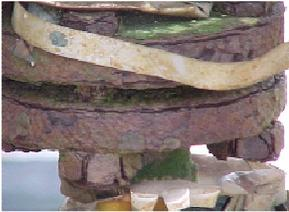
La brida de la izquierda está muy corroída, y los pernos están en muy malas condiciones – una fuga en potencia. Afortunadamente, esto fue notado durante una inspección de la Planta, y la brida fue remplazada (como se ve a la derecha).
