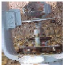
Gambar di sebelah kiri memperlihatkan katup kendali yang sudah korosi. Apakah anda dapat mengandalkan valve ini beroperasi ketika anda membutuhkannya ? Gambar di sebelah kanan menunjukkan penggantinya, dan jika dirawat dengan dan di-tes dengan benar dapat berfungsi dengan baik ketika dibutuhkan.
