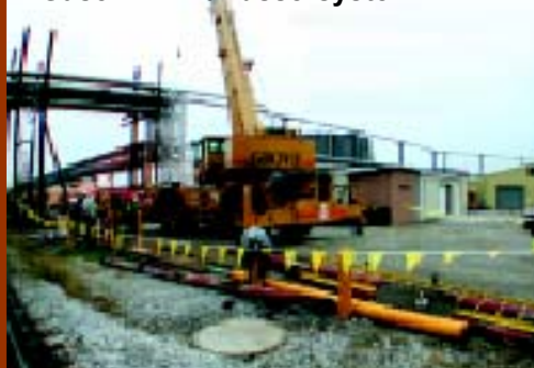
August – Bildung von giftigen Gasen im Abwassersystem
