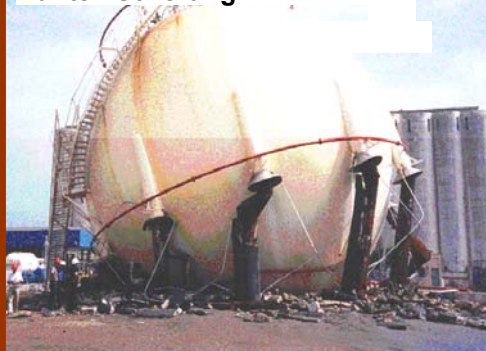
Februar – Korrosion unter Isolierung
