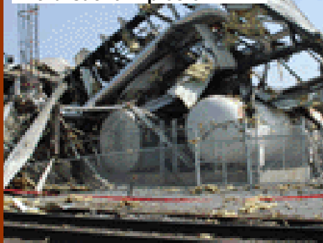
April – Überhitzung verursacht Explosion
