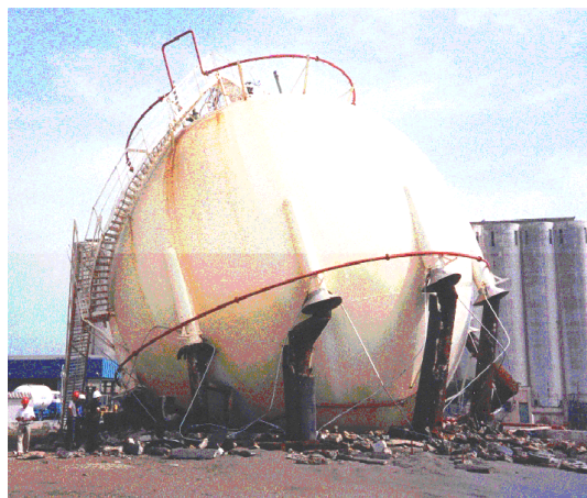
Η Διάβρωση Προσβάλλει Δομικά Υποστηρίγματα
