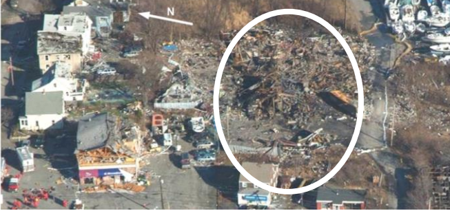
Şekil 1 Boya tesisi Patlama hasarı
