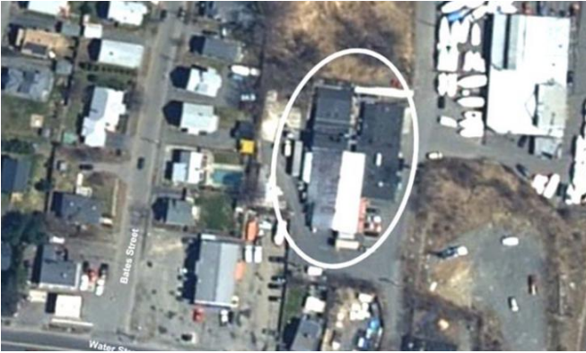
Şekil 2 Patlamadan önceki boya tesisi
