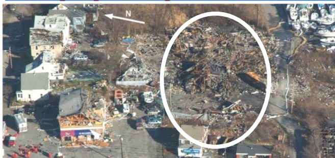
Rys. 1. Widok zniszczeń wytwórni farb po wybuchu
