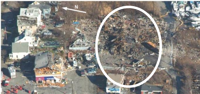
شکل ۱ خرابی ناشی از انفجار در واحد رنگ سازی
