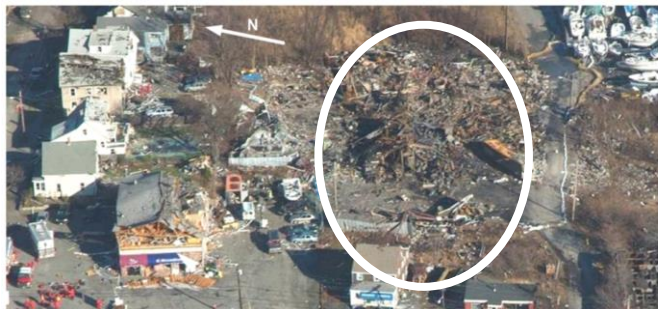
Figur 1 Malingfabrikken efter eksplosionen
