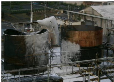
Abbildung 2. Tanks nach dem Brand
