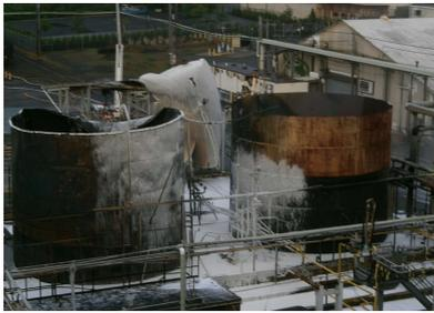
圖 2. 火災後的儲槽
