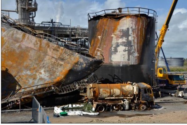
Şekil 1. Patlama ve yangın sonrası
