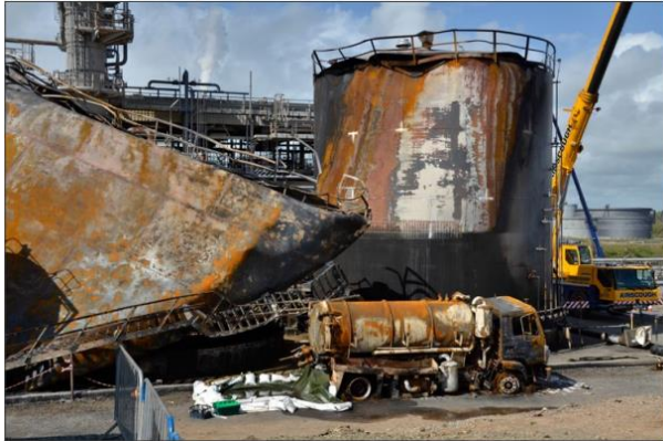
Figura 1. Urmările exploziei și incendiului
